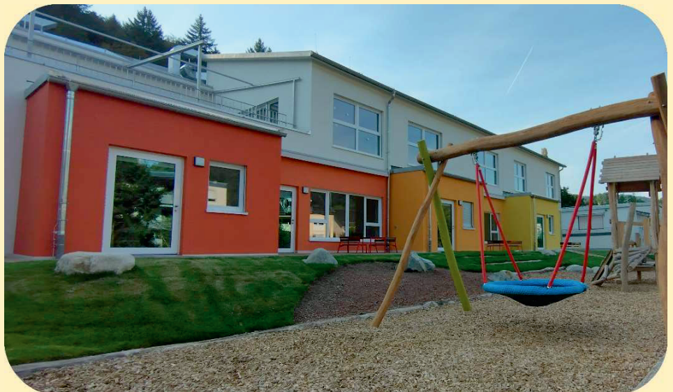
Außenanlage mit Spielplatz
