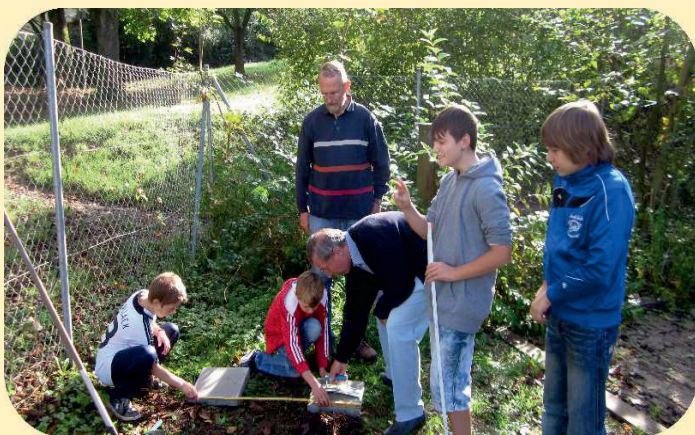
Arbeitsbeginn zum Bau eines Pizzaofens
